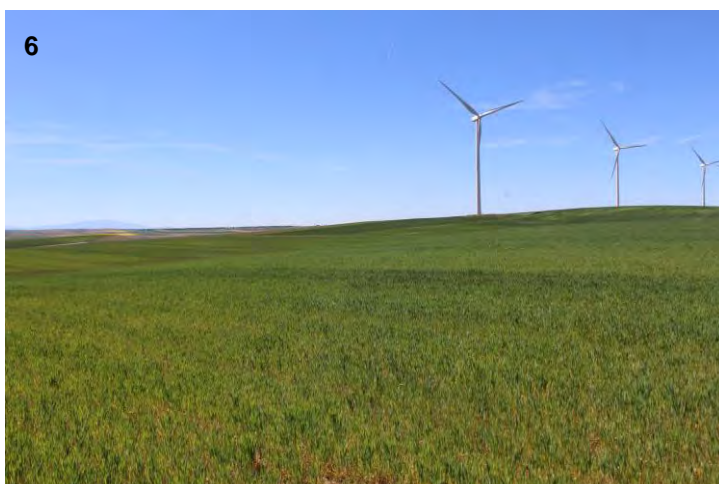
Fase I. La planta solar aprovecha infraestructuras del parque eólico en servicio. Desarrollo de la zanja sub. hasta los aerogeneradores implantados.
