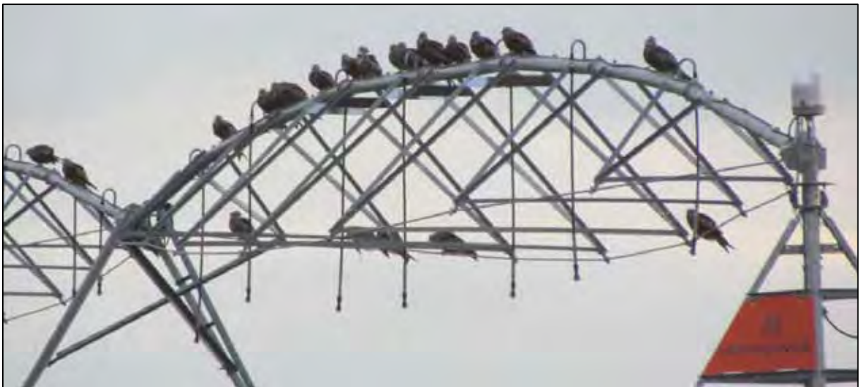
Figura 118. Predormidero sobre pivot. Enero 2023.
